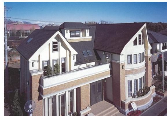
写真出典「新版屋根の知識」日本屋根経済新聞社
